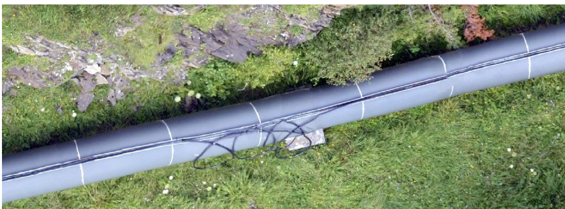
Figure 13 : extrait de l'orthoimage sur la partie haute de la conduite
