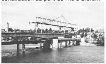
L'ouvrage fait partie de la génération des caissons en béton précontraint réalisés avant les années 70 qui ont montré des lacunes sur :
